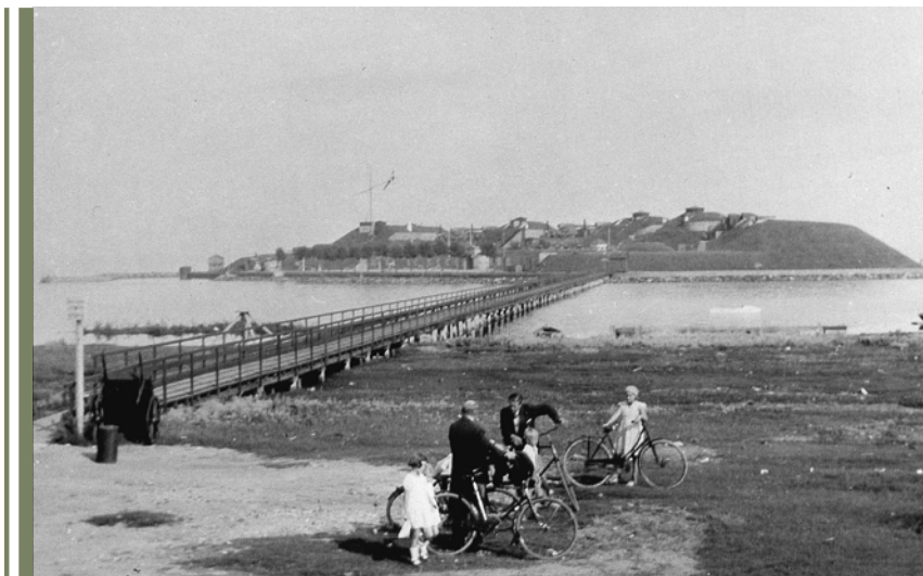
Dragørfortet ses her efter krigen. Billedet er fra engang i 1920'erne. Fortet blev bygget på en kunstig ø med en træbro indtil Dragørs strand. Foto: Dragør Lokalarkiv, B4577
