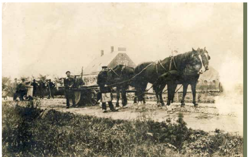
Tømmerupvejen tromles for at forbedre vejen ved Helgeshøj på Tømmerupvej 3. Tromlen trækkes af fire heste. Fotografiet er fra ca. 1910-1916. Foto: Tårnby Stads- og Lokalarkiv, B42
