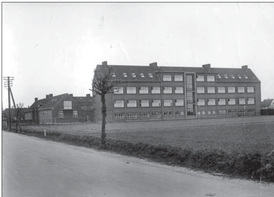
Den nye, høje bygning (fra 1932) set fra vest.
