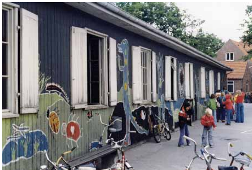
Barakken er blevet malet over med graffiti. 1975.
