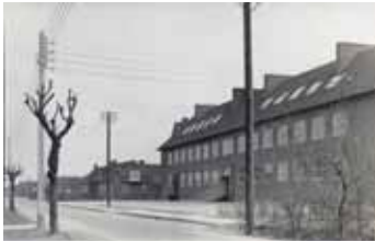
Teknisk skole og biblioteket med Korsvejens Skole yderst til venstre. Ca.1945.
