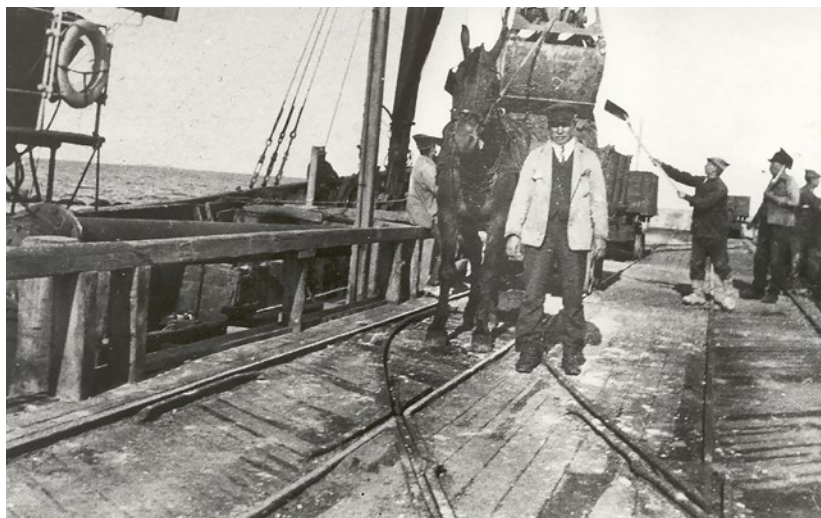
Arbejdet med at laste og læsse fra Syrebroen udførtes af arbejdsmænd. Et særligt spor til vognene gik ud på broen helt til ud til skibene. Hesten trak vognen. På billedet fra 1910 ses Henrik Madsen, som formentlig førte hesten. Foto: Tårnby Stads- og Lokalkarkiv, B4137
