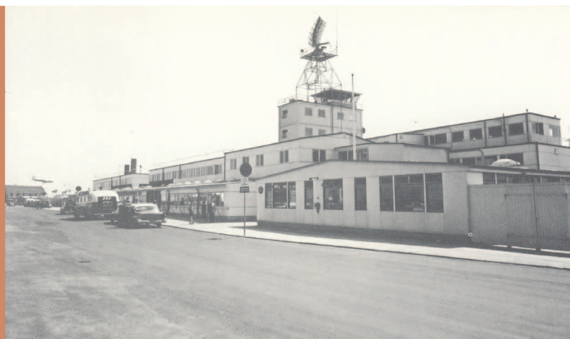
Tårnbygningens nederste etage er den gamle kontrolcentral. Etagen ovenover rummer Indflyvningskontrollen. Øverst Tårnet (glasburet). Faktisk består bygningen af tre etager, hvoraf den allernederste (ikke synlig) var til teknikerne. Foto ca. 1960.
