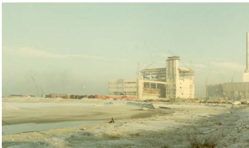
Amagerforbrændingen under opførelse, 19. december 1968.
