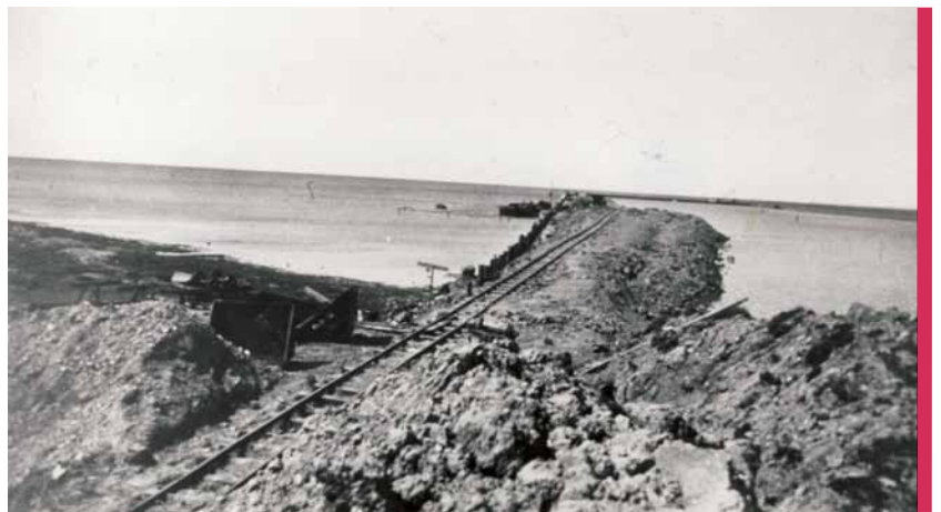
Inddæmning af Vestamager med tipvognsspor. Her ved skovgrøften fotograferet den 8. juni 1941.
