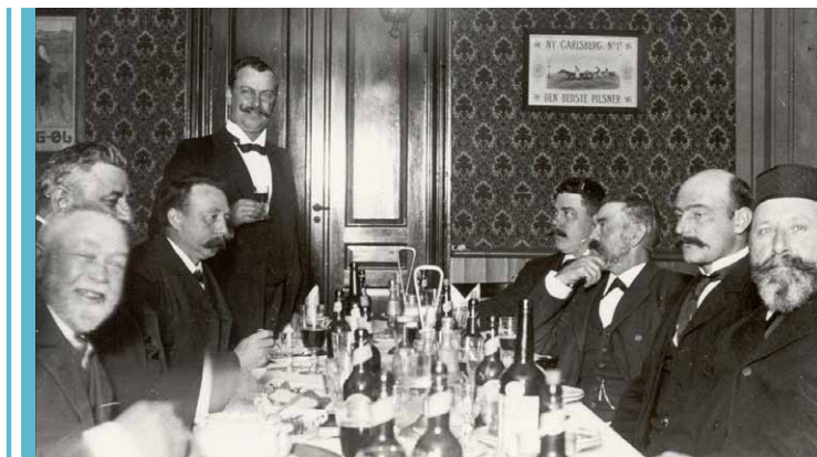
Kastrup bedre borgerskab hygger sig på Kastruplund. Til venstre A. Johnsen, der var involveret i de omtalte spareforeninger samt Amagerbanken. Stående Otto Rosenkilde. Ved den anden side af bordet fra højre, skoleinspektør A.C. Poulsen, en ukendt, tømrermester Marius Westh og brygmester Martin Larsen. Foto: Carl Flensburg, ca. 1905.
