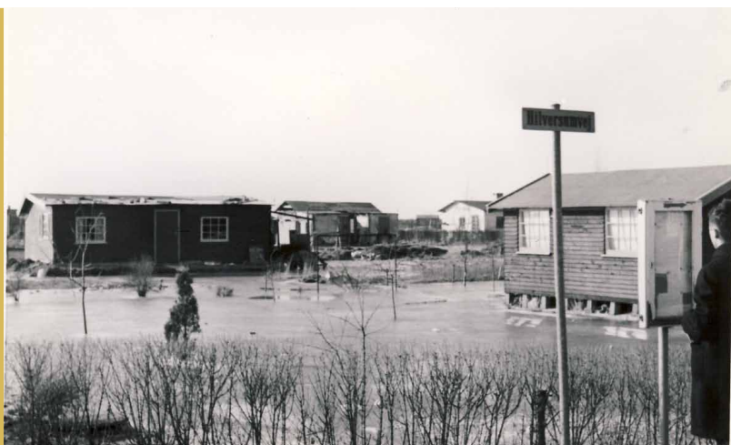
Et oversvømmet trist Vestamager ved Hilversumvej. Fotograf: Lange, Vinteren 1959-1960
