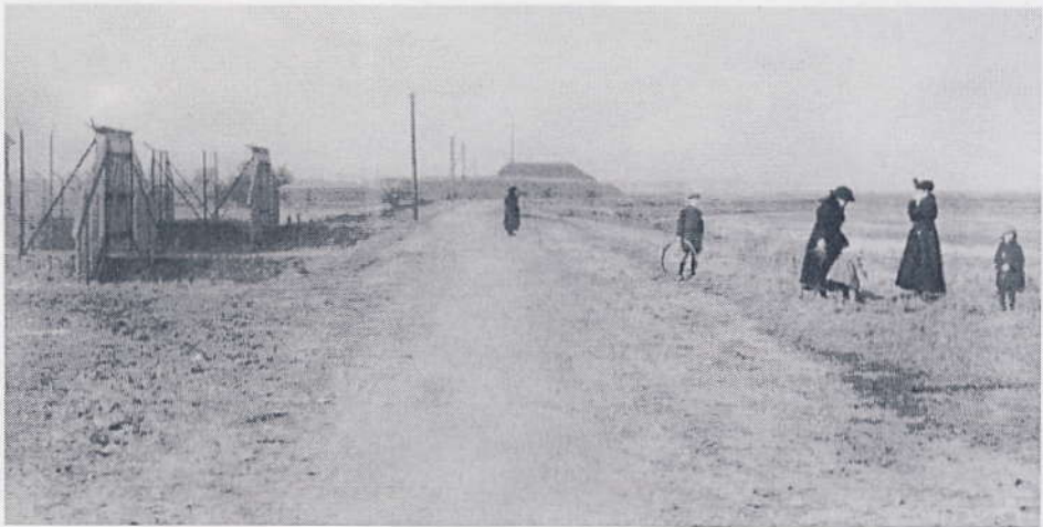
Den frigivne Krudttårnsvej ved lufthavnen, 1924.
